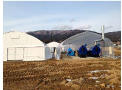
被災農地に建設中のビニールハウス (平成25年2月)
